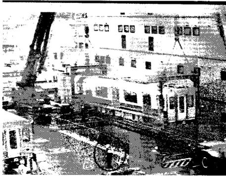
写真は地下鉄東西線の車両を醍醐車庫に搬入するシーンです。合い吊りといって二台のクレーンがバランスを取りながら、地上にあらかじめ開けてある穴から車体を地下の線路に先においてある台車の上まで下ろ
